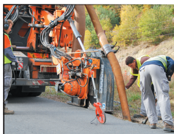
TRÈS HAUT DÉBIT : début des travaux
