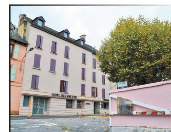
LION D'OR : travaux et installation de bureaux pour les agents départementaux
